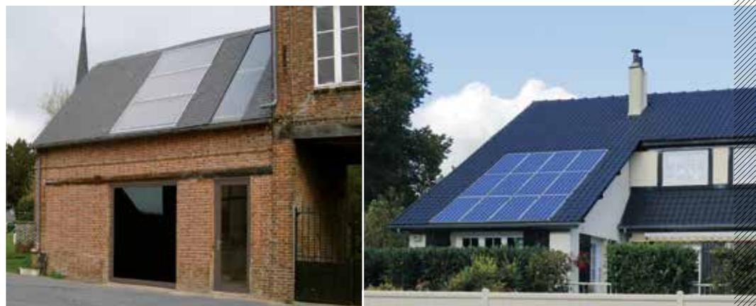
▲ Système solaire intégré à la toiture dans la continuité d'une ouverture existante en façade.
